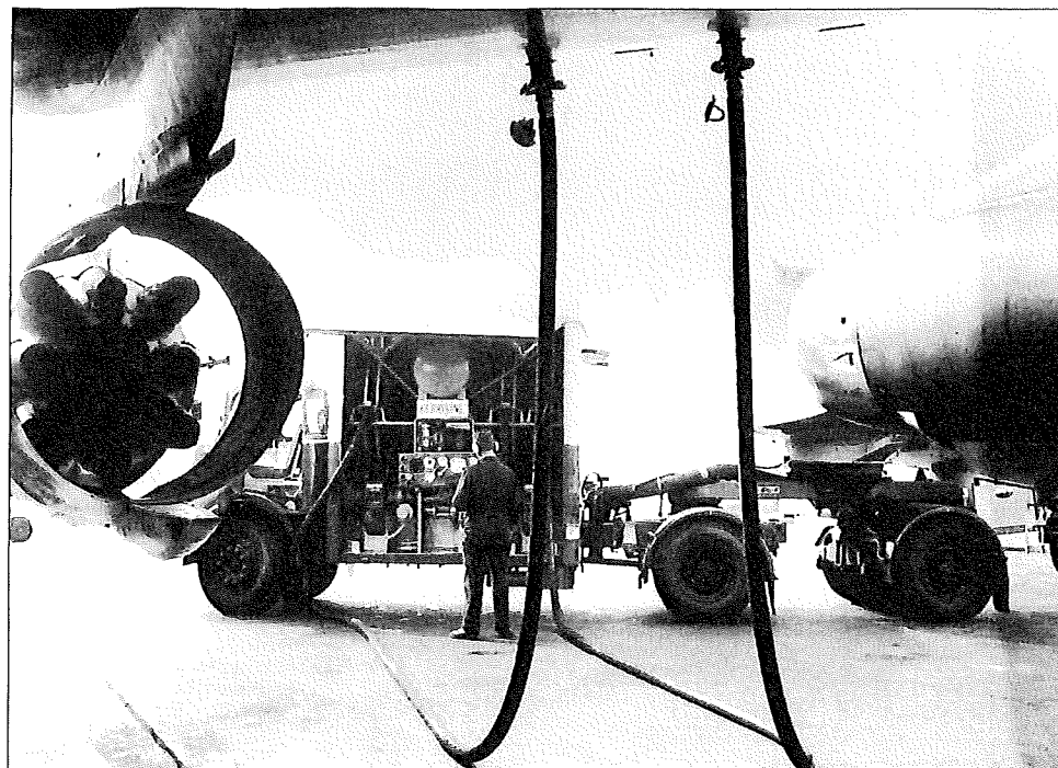
Geluiddempers, hier bij een DC-8, begin jaren zestig, verhoogden het brandstofverbruik.
