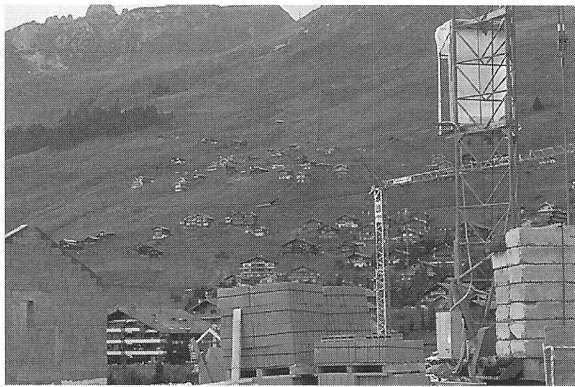
Bouw van toeristische accommodaties ten koste van hellingbos.
